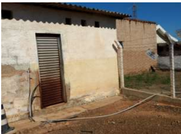
Foto 3.18 – Unidade de tratamento do Poço 05
