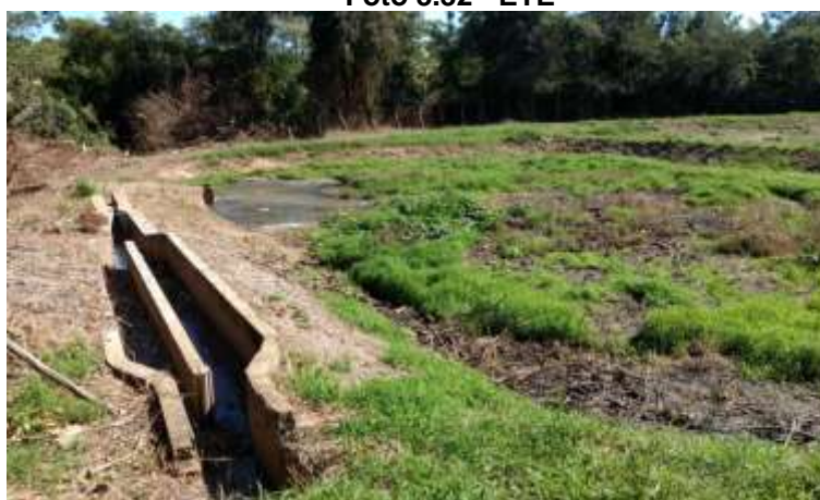
Foto 3.33 – Tratamento Preliminar e Lagoa Anaeróbia
