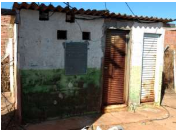
Foto 3.16 – Unidade de tratamento do Poço 03
