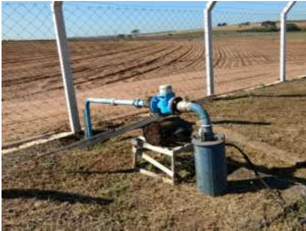
Foto 3.13 - Identificação do Poço: Poço Porto Belo
