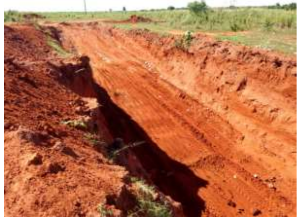
Foto 3.40 – Vista do aterro sanitário – Vala
