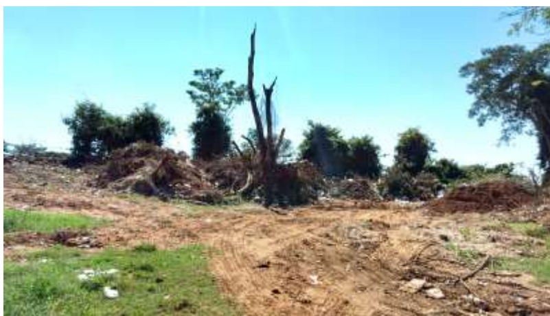
Foto 3.43 – Vista do depósito irregular de RCC e poda
