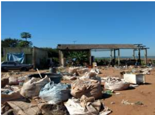
Foto 3.39 – Entrada do aterro sanitário
